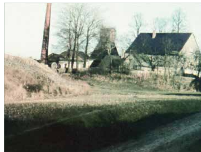
Основное здание Нойяр-шахт (1940)
