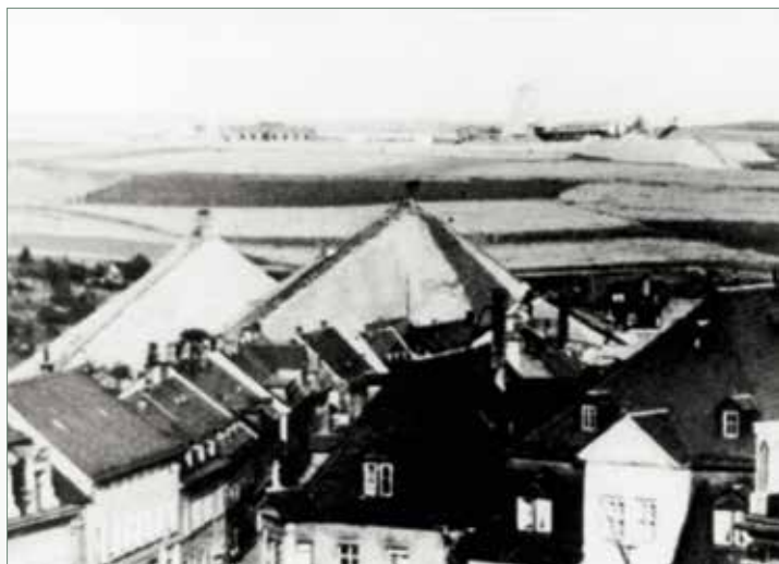
На фото слева: на переднем плане — отвалы Риттер-шахт, на заднем плане — шахта №76 (1950 г.) На фото справа: штольня в районе Грундштрассе-Штоленхоф (1948—1949)
