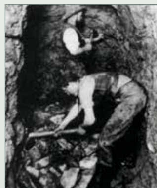
Проходка с молотком и буровым долотом (фото 1930 г.)
