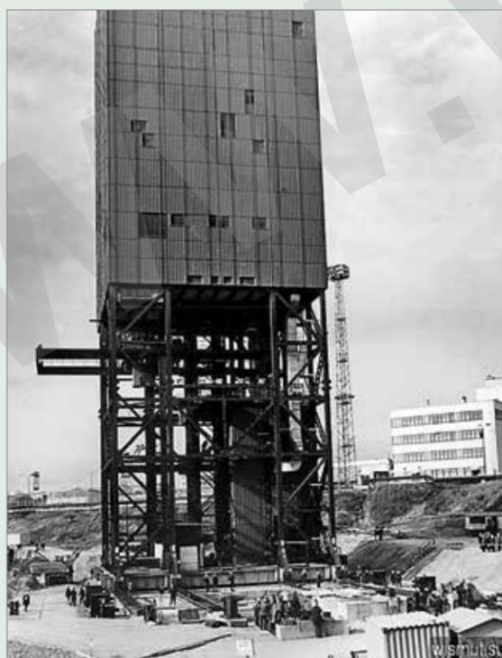
Башенный копёр весом 5000 тонн смонтирован и надвигается на устье ствола 415 рудника Дрозен. (Из архива В.Н. Кузнецова)
