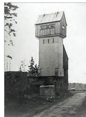
Шаар-шахт. Подъемный копер.
