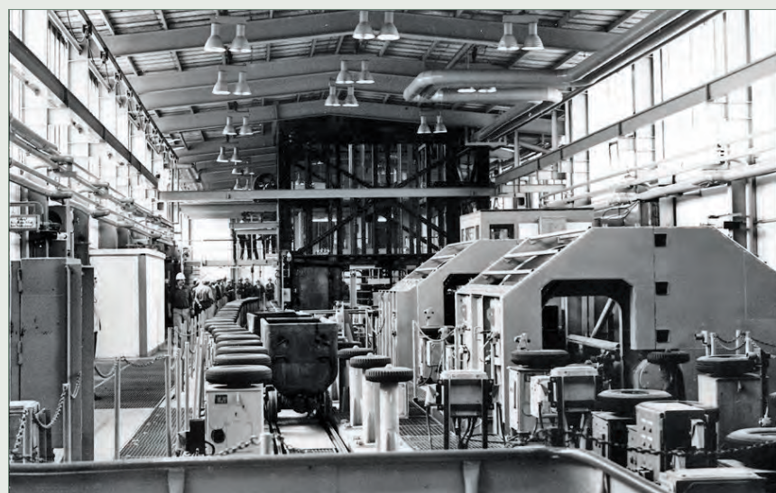
Поверхностный комплекс обмена вагонеток на стволе 403 рудника Дрозен.
