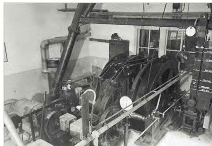
Гюнтер-шахт. Подъемная машина.
