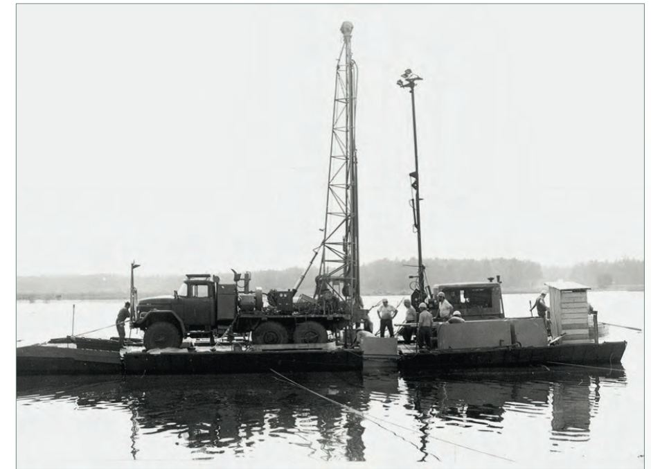
Буровая установка URB 2,5 A на понтоне во время разведки залежей бурого угля на участке Клиттен (Оберлауцицкий озерно-луговой ландшафт) (фото из архива Wismut GmbH).
