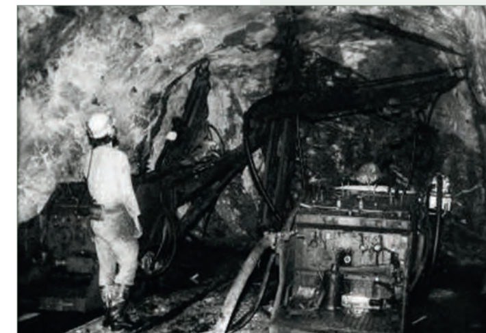
Буровые каретки СБКНС-2. Справа: в забое (фото из архива Wismut GmbH).
