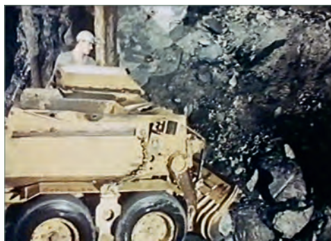
Погрузочно-доставочная машина ЛБ-125/1000 в забое (фото из архива Wismut GmbH).
