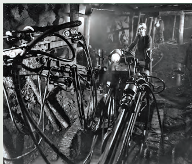
Буровая каретка РБГ-16, производства висмутовского завода Гормаш Ауэ. В очистном забое блока.
