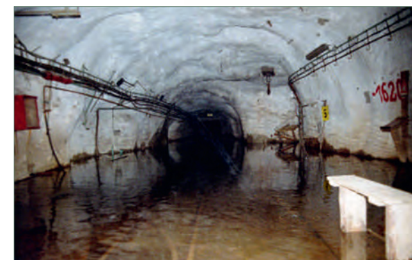
Затопление выработки на горизонте -1620 м (фото из архива Wismut GmbH).
