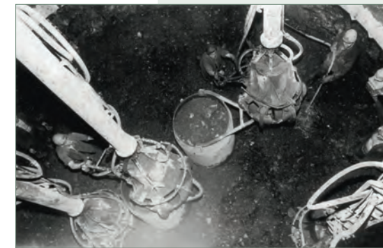
Работа с грейфером в забое ствола (фото из архива В. Н. Смирнова).
