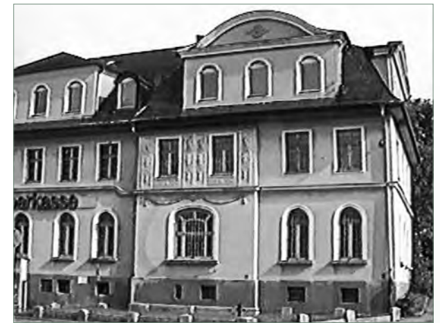
Отдел механизации в здании шпаркасси, на третьем этаже (1993 г.).
