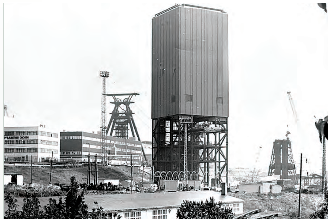
Строящийся рудник Дрозен (1978 г.). На переднем плане — башенный копер ствола 415.
