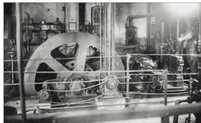
Рудник Вайсер Хири. Подъемная машина.
