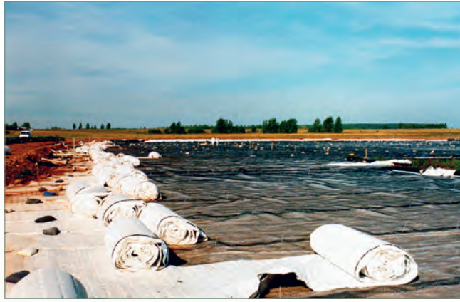
Хвостохранилище Кульмич, промежуточная изоляция (фото из архива Wismut GmbH).
