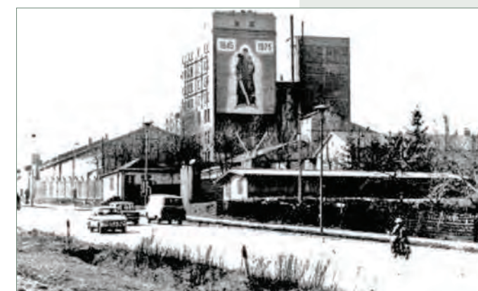
Цех опробования № 50 (Ауэ).
