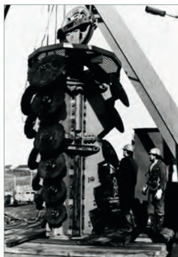
Проходка ствола № 390 в районе руддвора –94 м (фото из архива Wismut GmbH).
