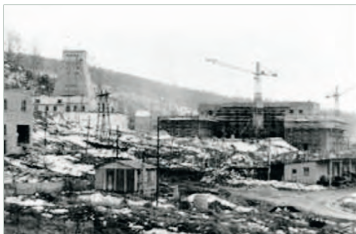
Шахта № 371 в период строительства (1957–1958) (фото из архива Wismut GmbH).
