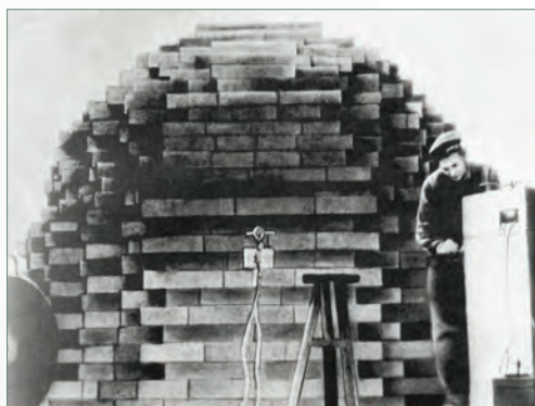
Первый исследовательский уран-графитовый реактор Ф-1. Пущен 25 декабря 1946 г. Предназначался для экспериментальной проверки осуществления цепной реакции деления и получения плутония в малых количествах.
