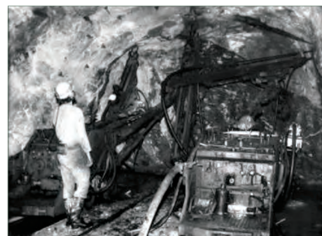
Буровые каретки СБКНС на проходке двухпутевой выработки.
