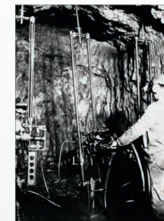
Буровая колонка К1Р в забое (фото из архива Wismut GmbH).
