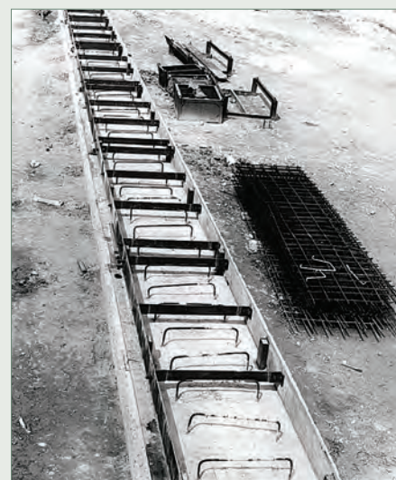
Подготовка направляющих лент для надвигки копра.
