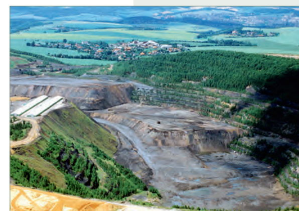
Засыпка карьера Лихтенберг, 1997 г. (фото из архива Wismut GmbH).
