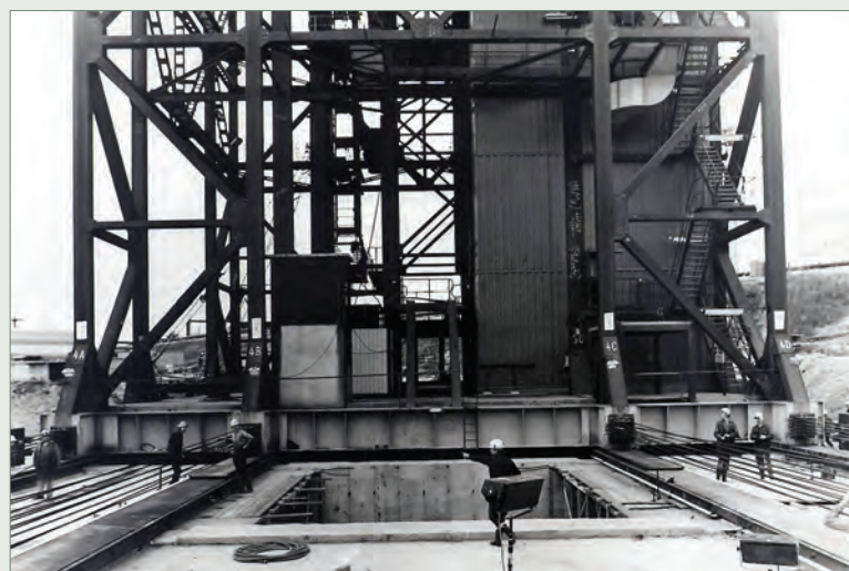
Башенный копер на завершающей стадии передвижки на устье ствола.
