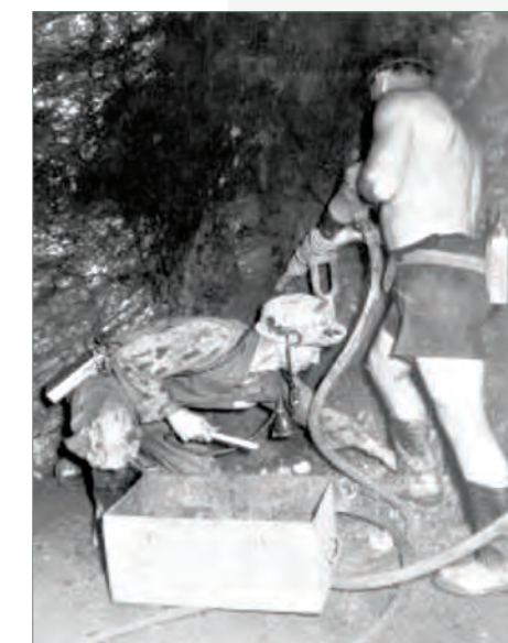
Отбойка богатой руды и ручная сортировка в забое (начало 50-х гг.).
