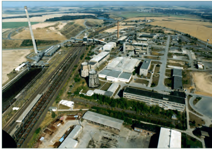
Общий вид рудника Беервальде (фото из архива Wismut GmbH).
