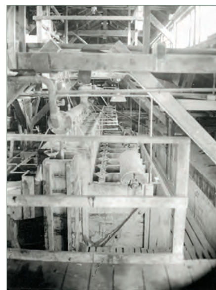
Обогатительная часть рудника Вайсер Хири. Флотационная машина.
