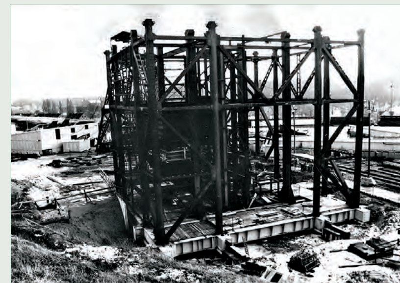
Начало монтажа копра на передвижной платформе.
