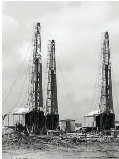
Буровые установки УКВ 650М при бурении специальных скважин для замораживания воротника ствола шахты № 416 на месторождении Дрозен (фото из архива Wismut GmbH).
