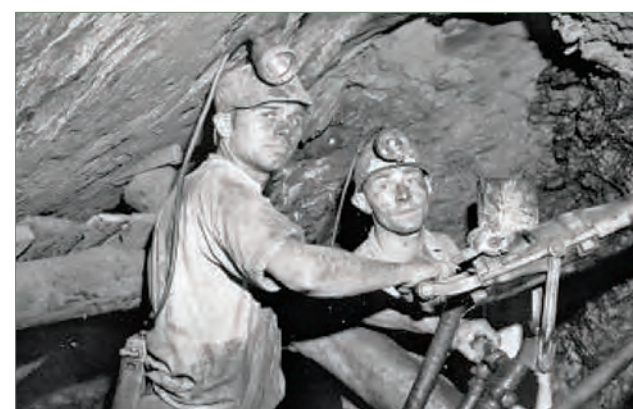
Бурение шпуров в очистном блоке (начало 50-х гг.).
