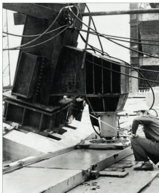
Перемещение копра № 403 на кессонной воздушной подушке (Frank Wolf, Klaus Hinke. «Bergbaubetrieb Drosen Uranerzgewinnung und Sanierung», August 2004, Wismut GmbH).
