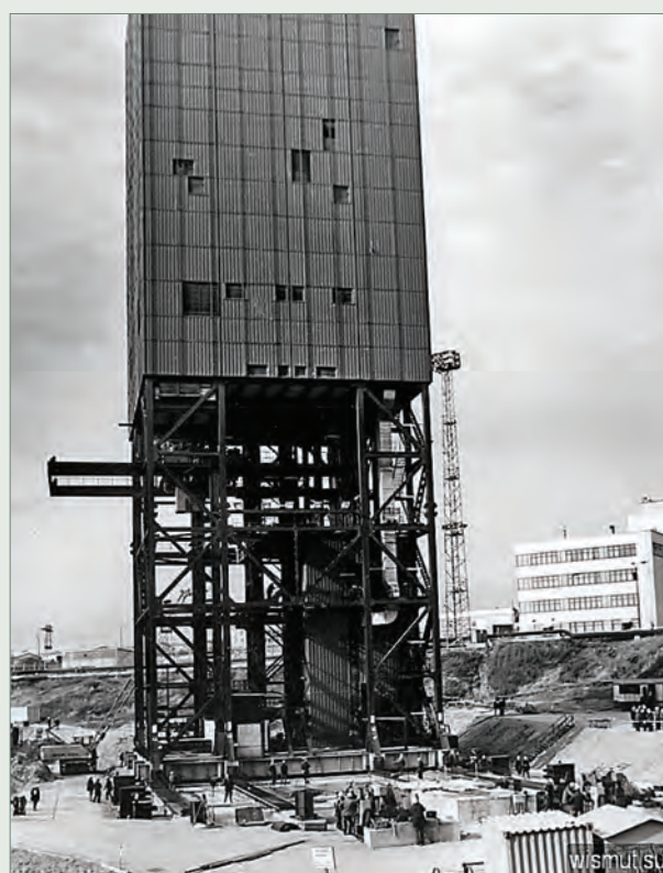
Башенный копёр весом 5000 тонн смонтирован и надвигается на устье ствола 415 рудника Дрозен. (Из архива В. Н. Кузнецова).
