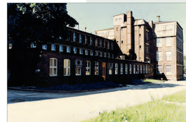
В этом здании НТЦ в Грюне на втором этаже была лаборатория вентиляции (фото из архива Wismut GmbH).
