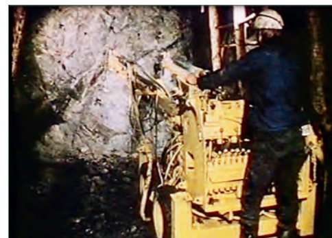
Буровая каретка БВА в забое (фото из архива Wismut GmbH).
