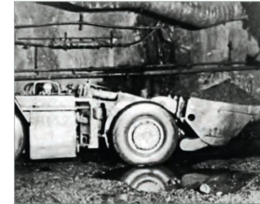
Слева: Первый образец подземного самосвала на площадке завода KRB (фото из архива Wismut GmbH).
